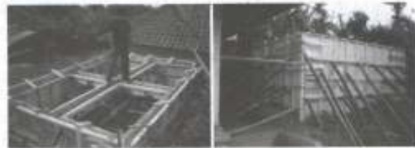
Gambar 8. Pembuatan reservoir baru.
